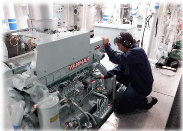
〈写真〉発電機の機関整備
