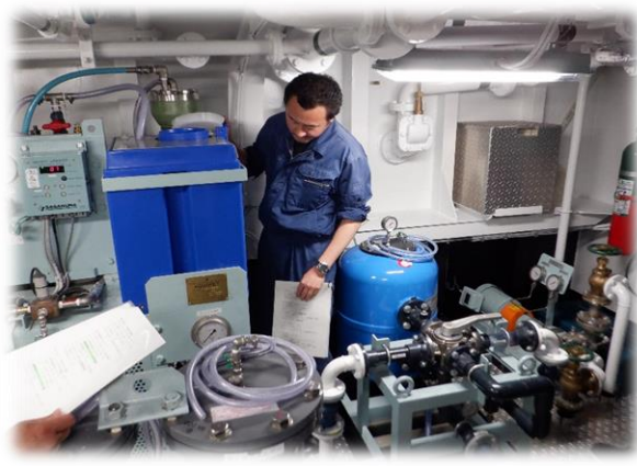
〈写真〉造水機の機関整備
